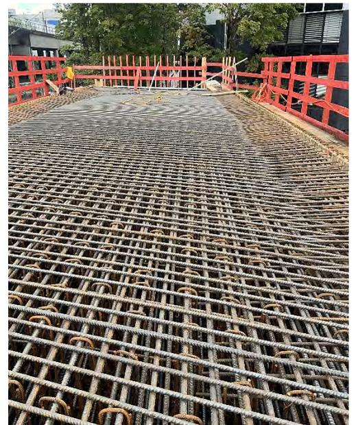
*Bauwerk in Seitenlage und Bewehrung des Überbaus*
